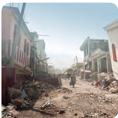
Terremoto en Haití, 12 de enero 2010. Condición en la que quedaron muchos edificios en Puerto Príncipe.
